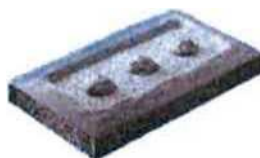
Rys. 1. Nakładanie kleju na płytę termoizolacyjną
